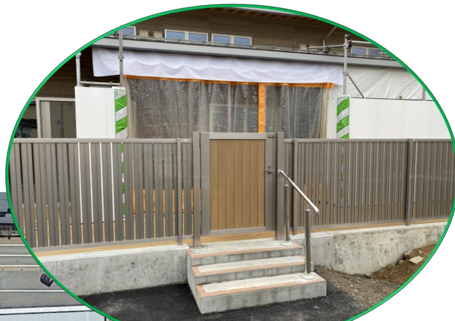
南側仮設玄関口
